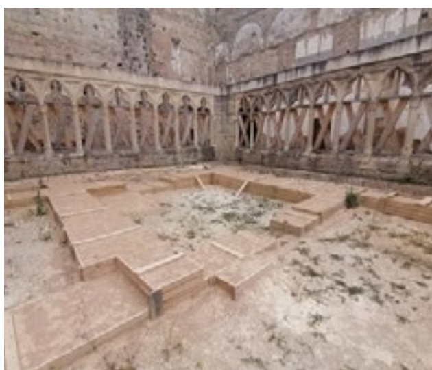
Morella: protección de restos del claustro
