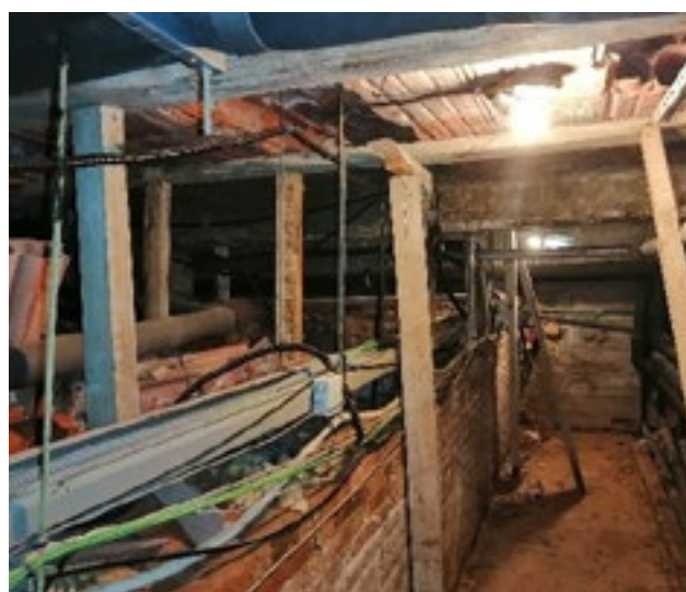
Parador de Benicarló: consolidación forjado del sótano
